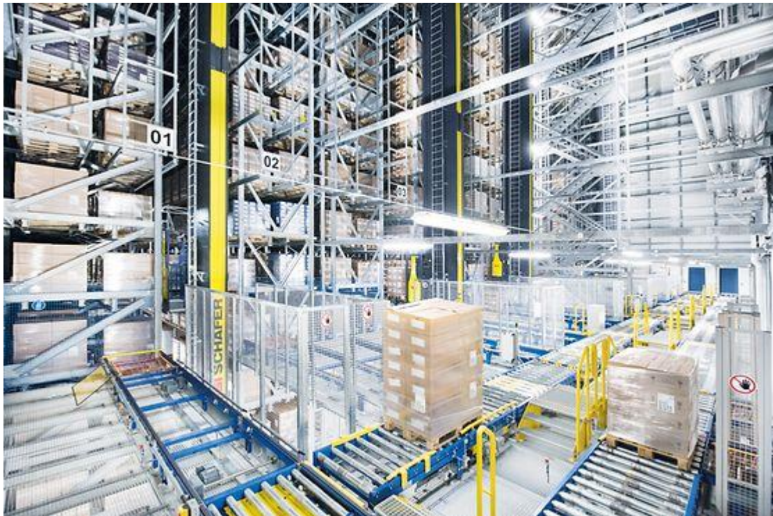
Slika 12. Primjer automatiziranog skladišta (Schaefer)
