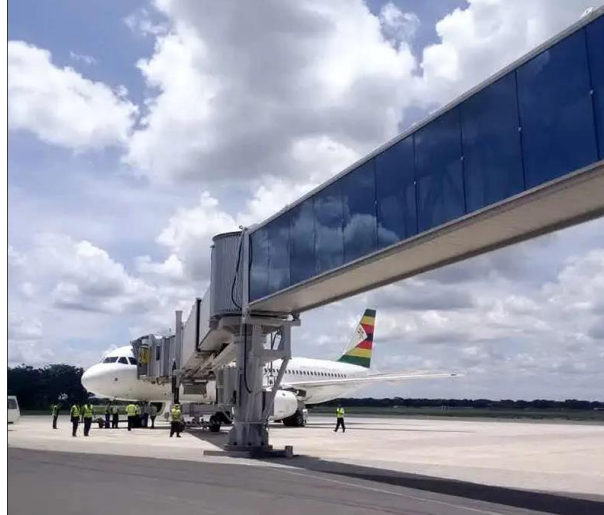
Slika 11. Primjer aviomosta.
