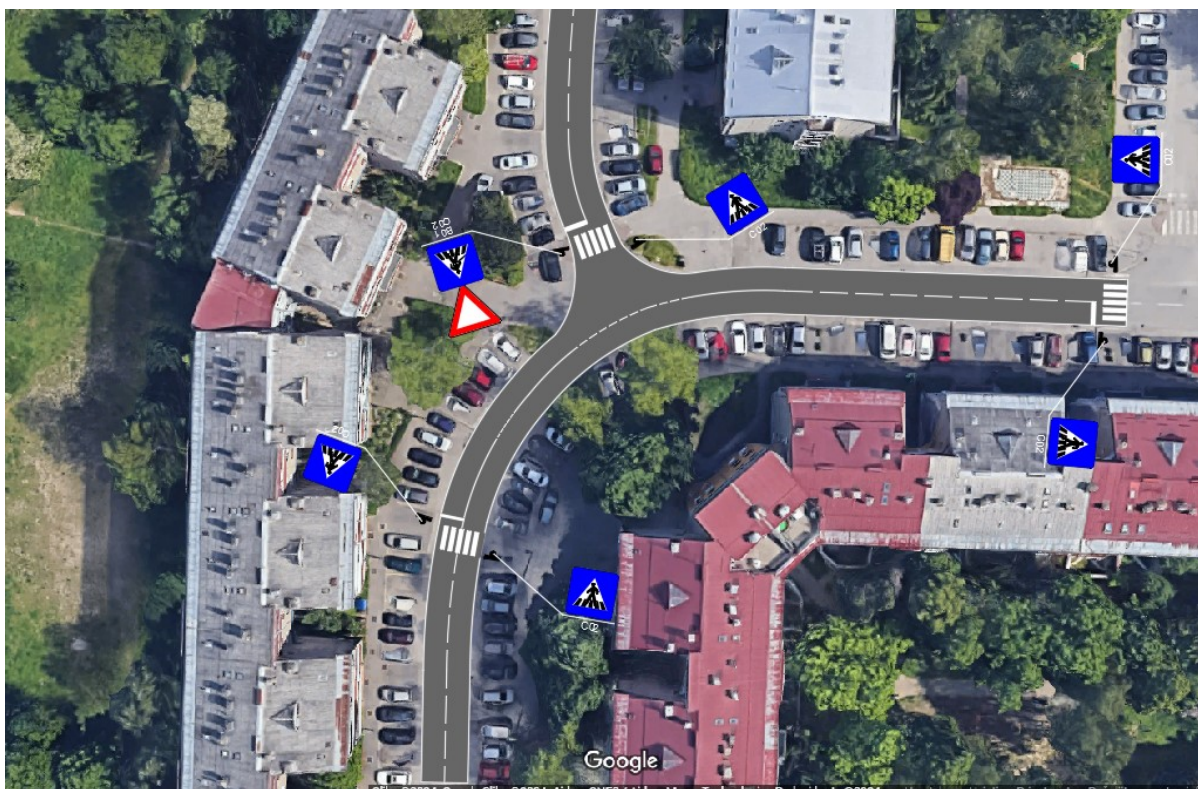
Slika 19. Postojeće stanje raskrižja ulice Milana Rešetara i Drage Gervaisa
