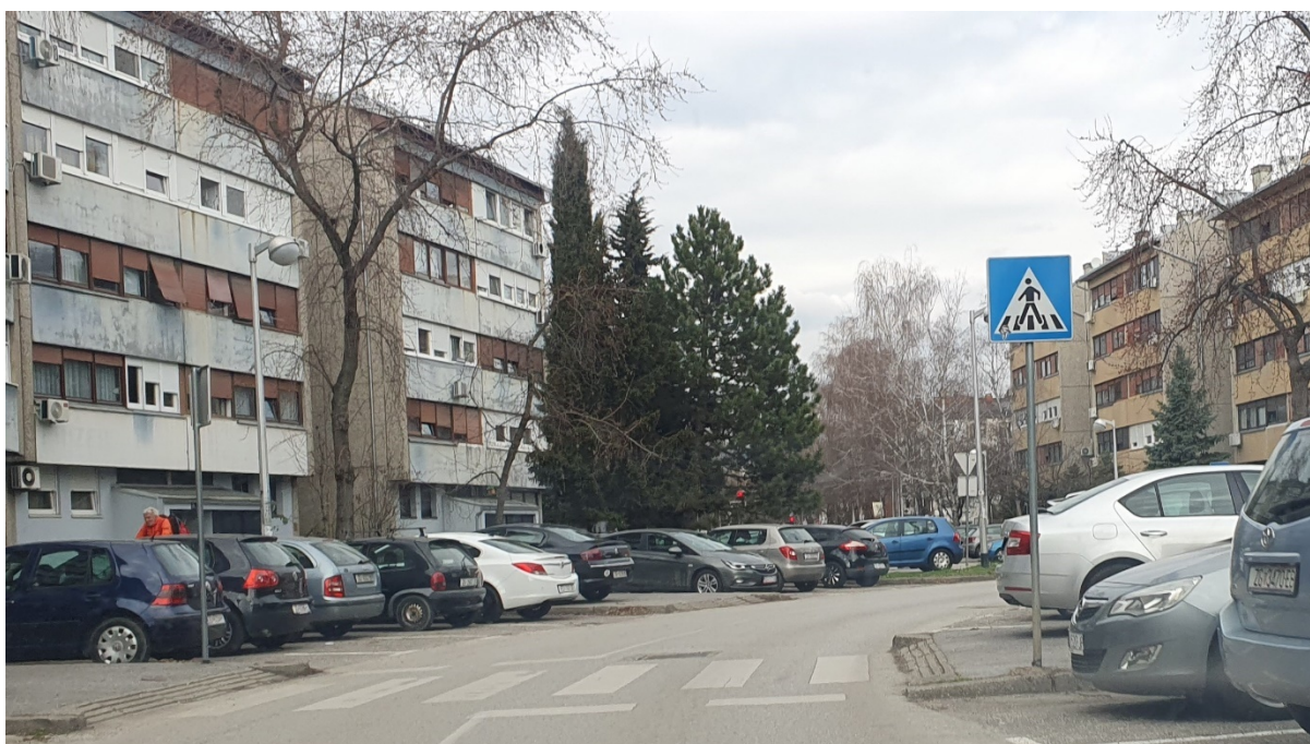
Slika 16. Privoz 1 - izmaknut pješački prijelaz radi nedovoljne preglednosti - MR - DG
