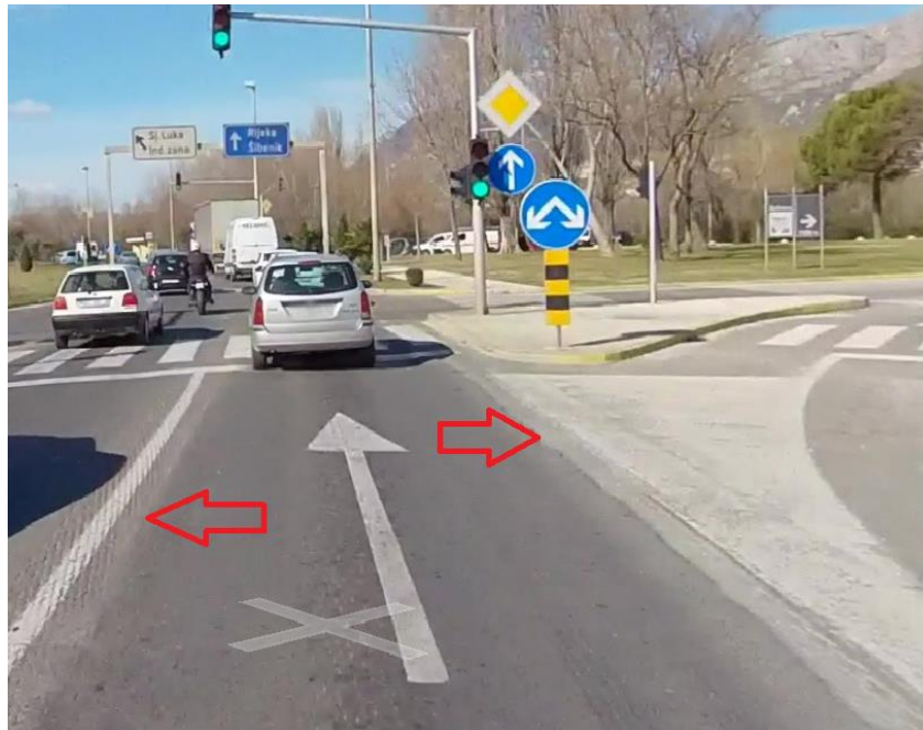
Slika 22. Kolotrazi (niski stupanj)
