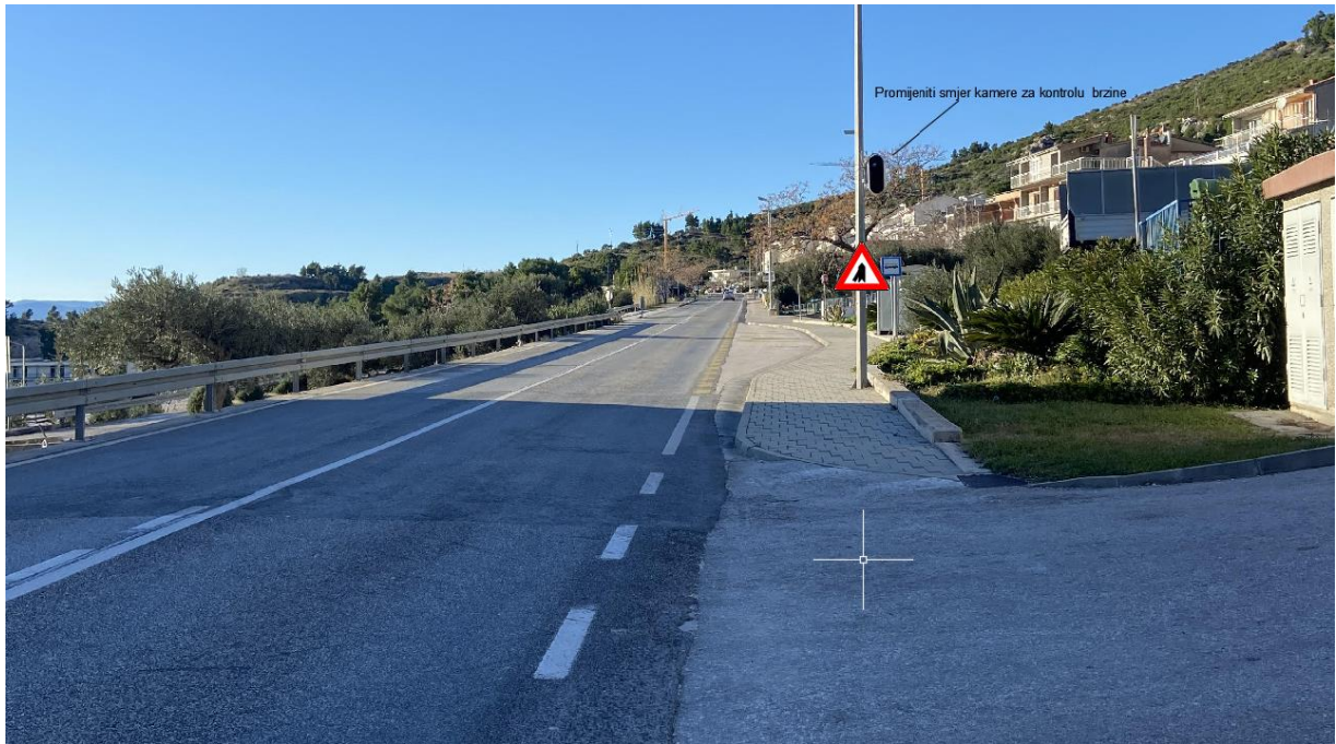
Slika 30. Prijedlog postavljanja prometnog znaka A06 i promjene smjera kamere za kontrolu brzine u Tučepima
