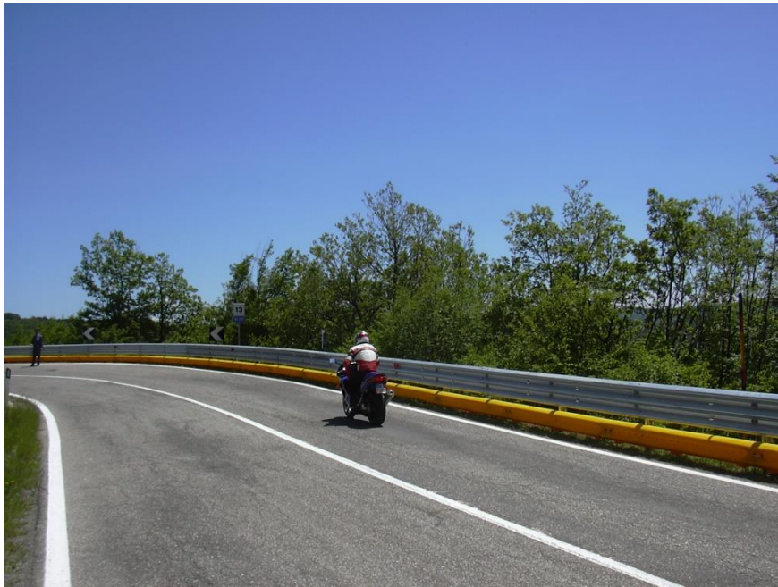
Slika 32. Dodatna zaštita od podlijetanja na zaštitnoj ogradi, [16]
