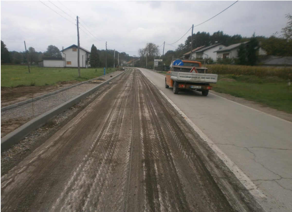
Slika 22. Skidanje habajućeg sloja asfalta
