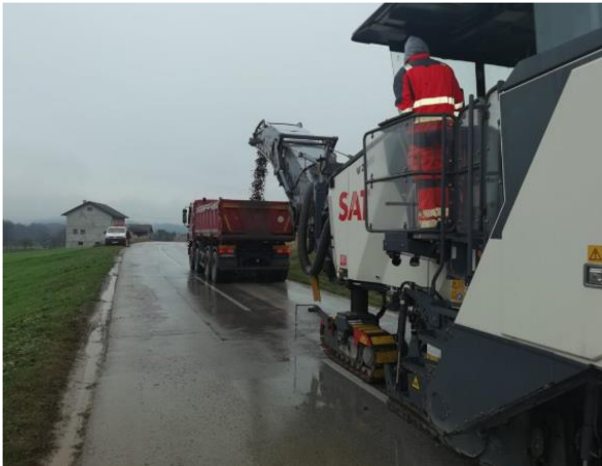
Slika 7. Skidanje (freziranje) asfalta
