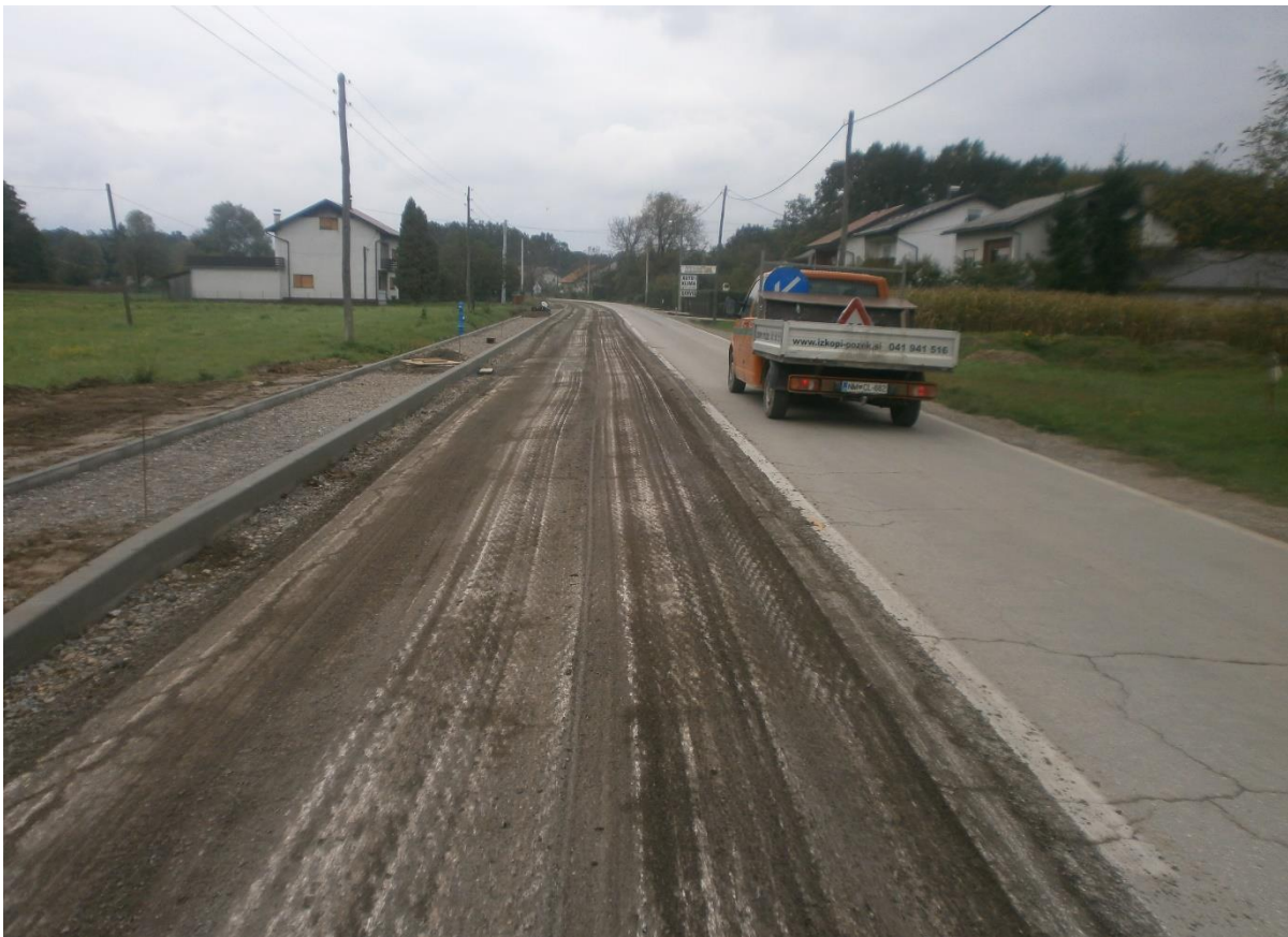
Slika 22. Skidanje habajućeg sloja asfalta
