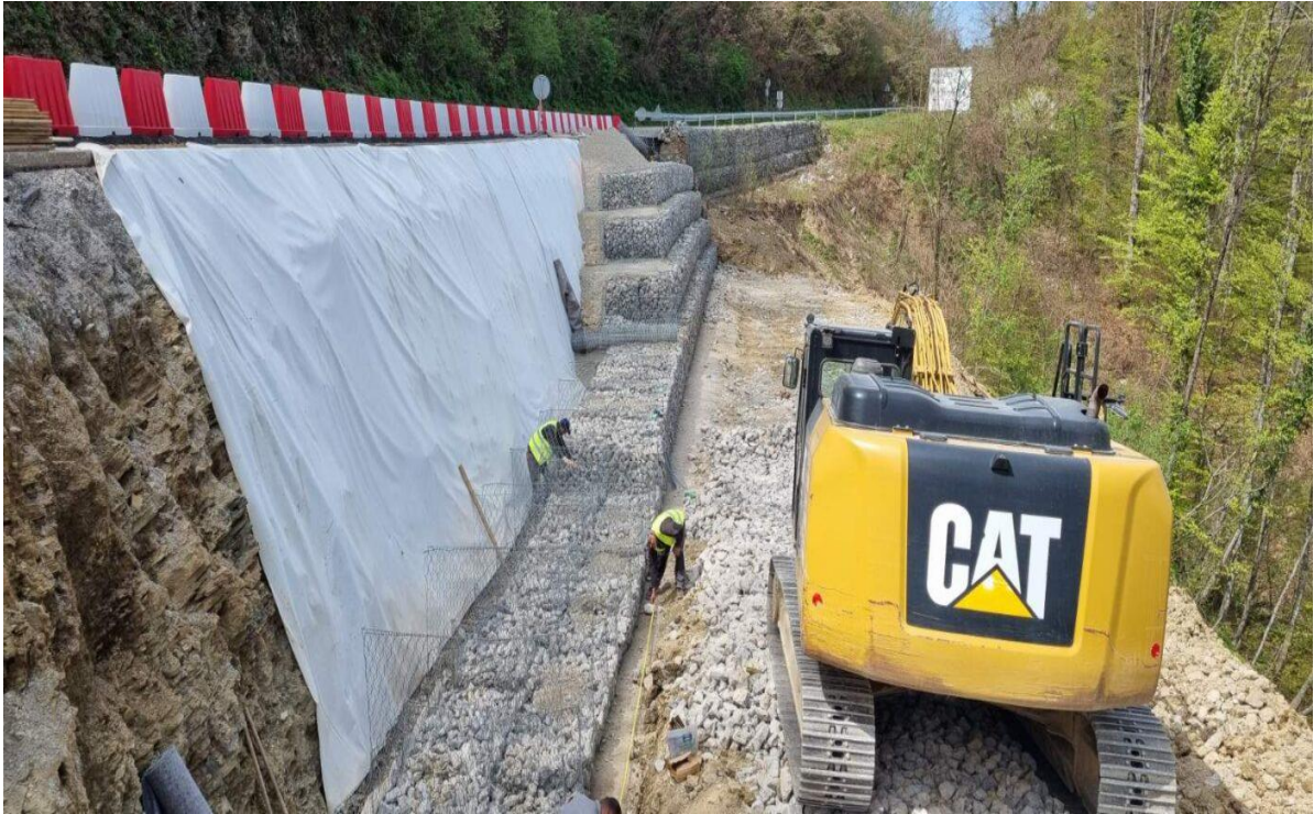
Slika 24. Sanacija klizišta na dionici Karlovac – Slunj
