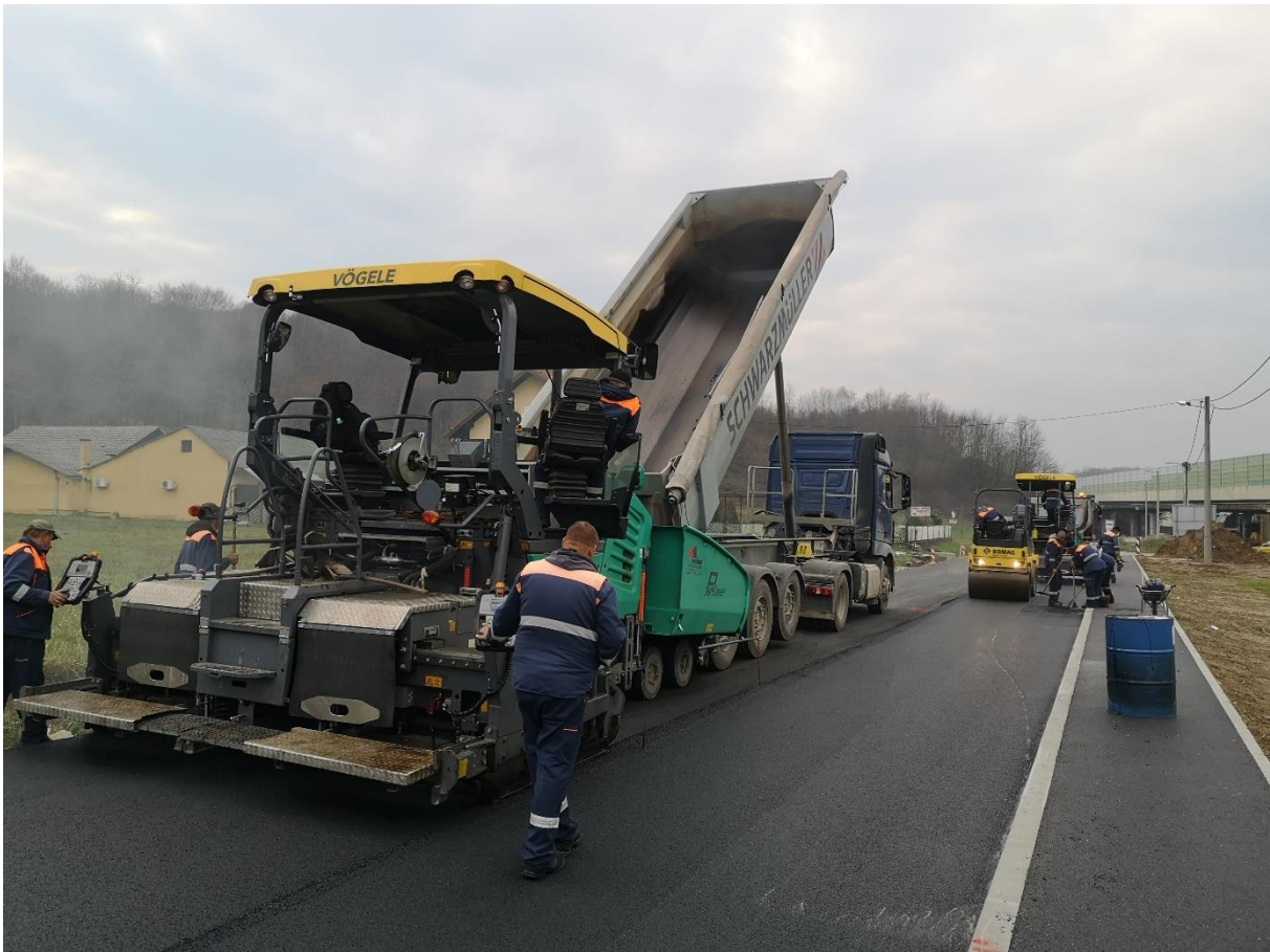
Slika 9. Postavljanje asfalta
