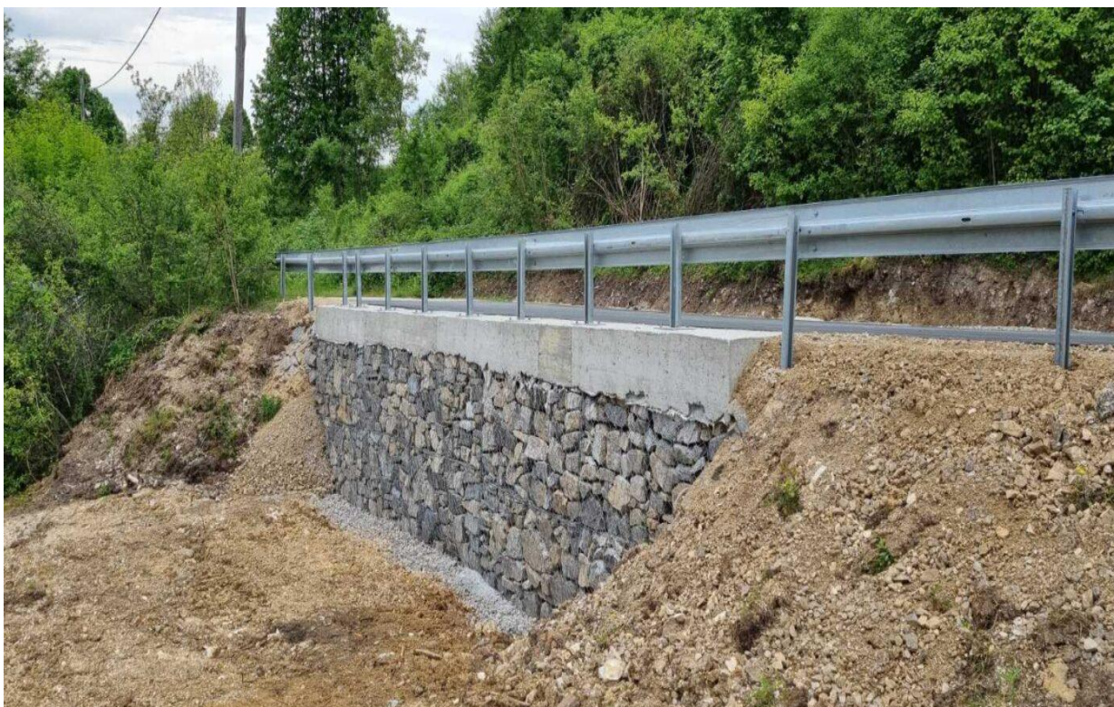
Slika 27. Sanacije ceste i padine kod Veljuna
