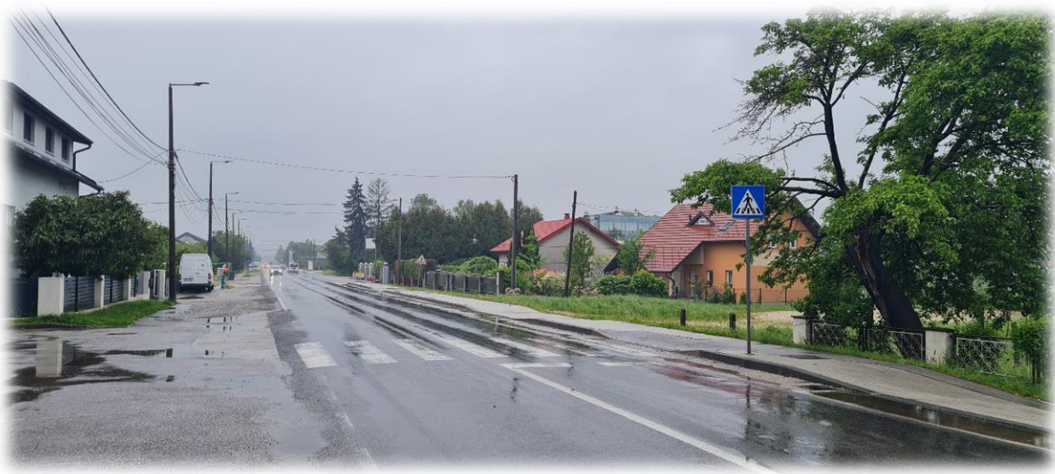
Slika 23. Pješački prijelaz ocrtan na kolniku sa znakom
