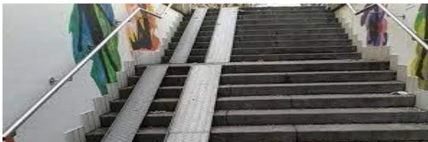
Slika 12. Kanalica za bicikl
