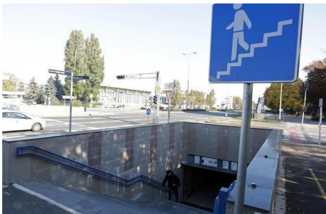
Slika 23. Primjer pješačkog podhodnika
