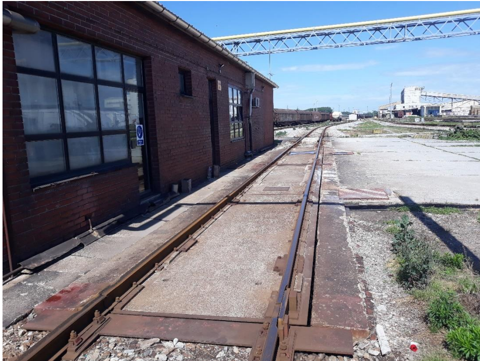
Slika 8. Mosna željeznička vaga
