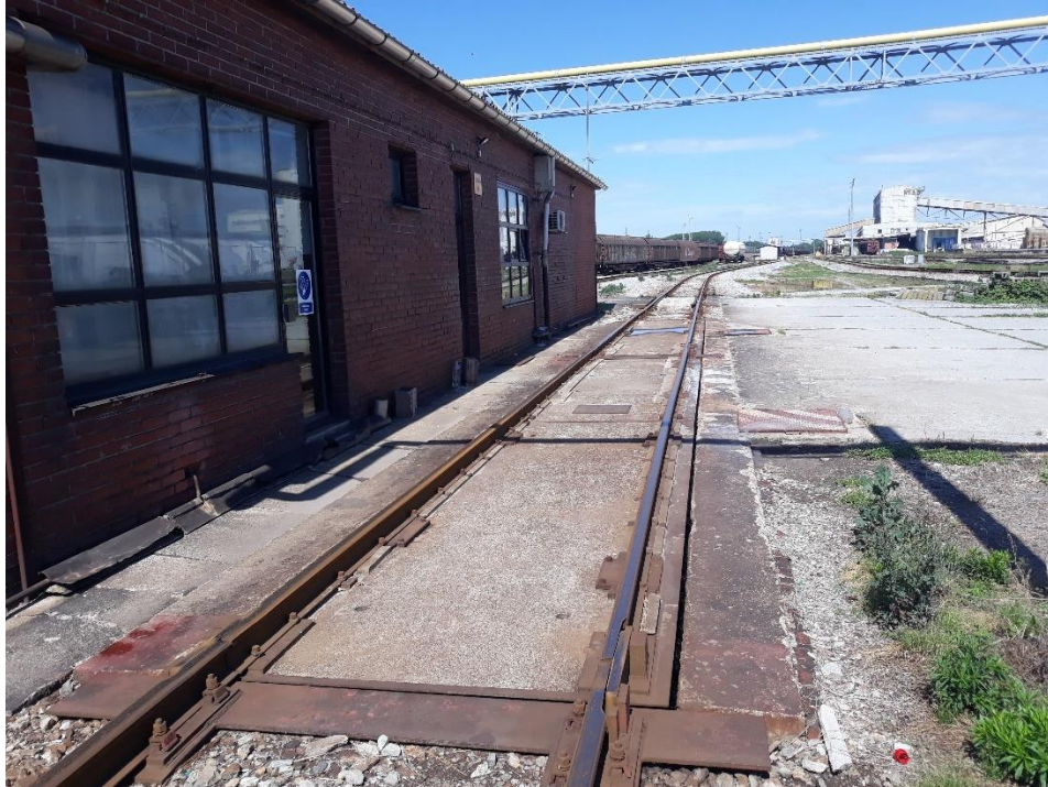
Slika 8. Mosna željeznička vaga
