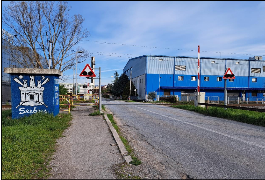
Slika 7. Željezničko cestovni prijelaz 01 "Mega" smjer Jug - Sjever
