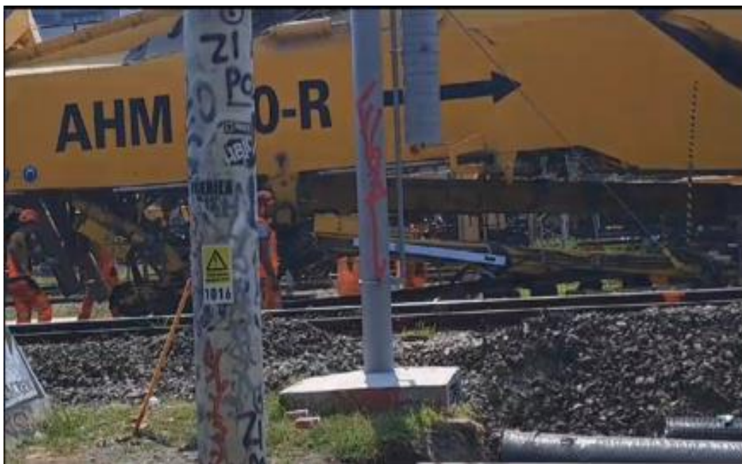
Slika 20. Radovi na donjem ustroju pruge
