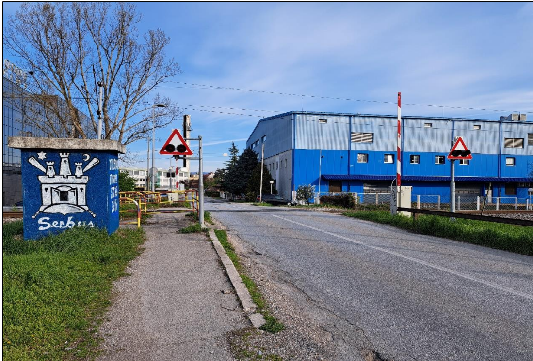
Slika 7. Željezničko cestovni prijelaz 01 "Mega" smjer Jug - Sjever
