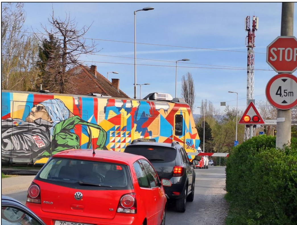
Slika 22. Križanje željezničke pruge s drugim prometnicama
