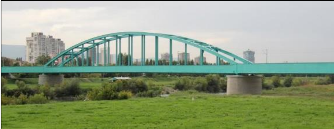
Slika 21. Most na željezničkoj pruzi
