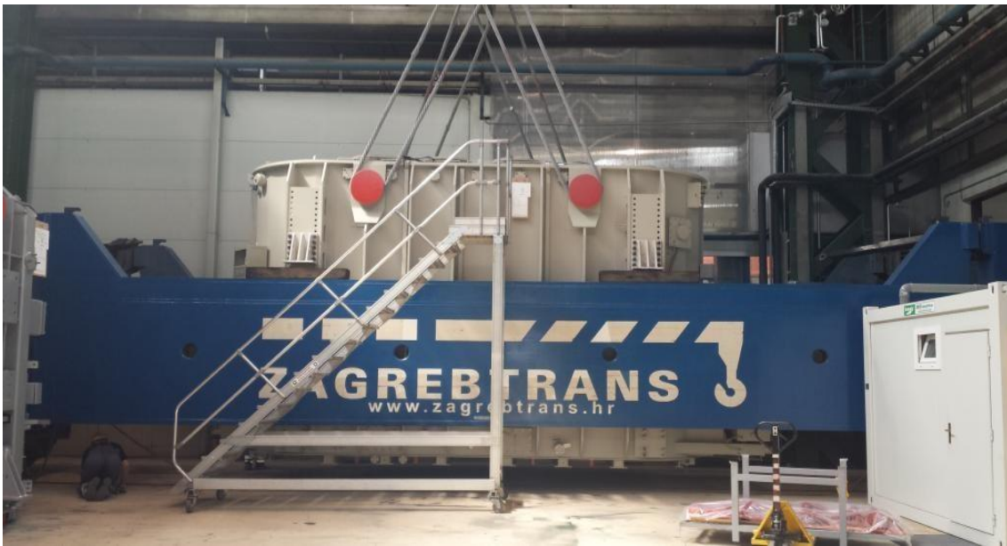
Slika 10. Ukrcanj transformatora Izvor: ZAGREBTRANS d.o.o. 2022.
