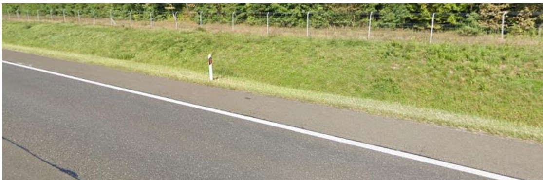
Slika 17. Silazni nagib uz cestu promatrane dionice bez adekvatne zaštite
