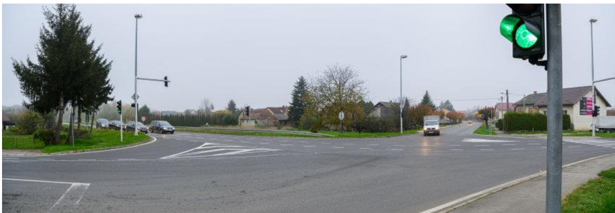
Slika 18: Raskrižje državne ceste D3 s Vukovarskom i Topličkom ulicom
