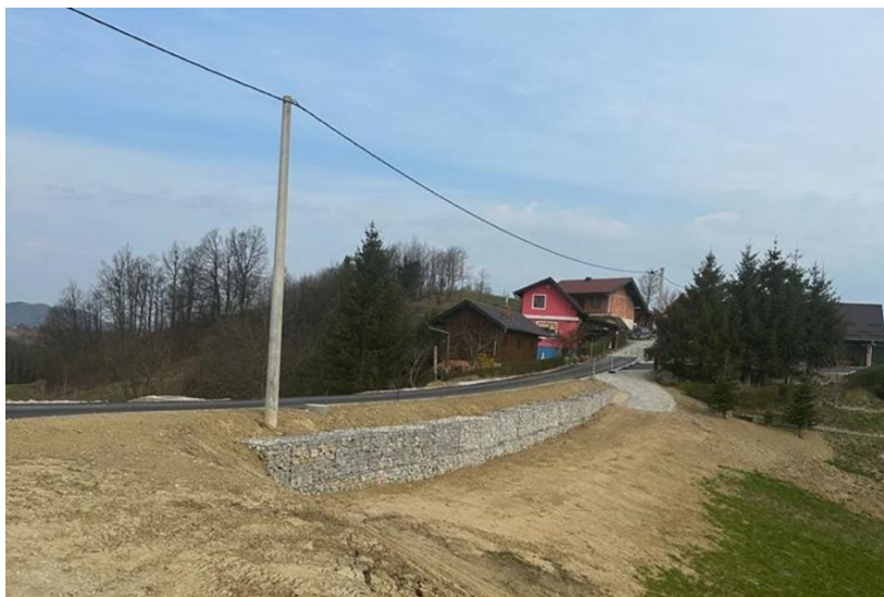
Slika 14: Sanacija klizišta u naselju Cvetlin, općina Bednja
