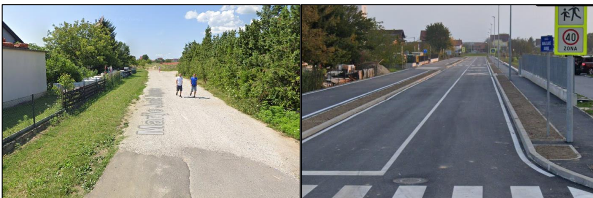
Slika 9. Prikaz izgradnje pješačke površine Izvor: autor uz korištenje „Google mape“
