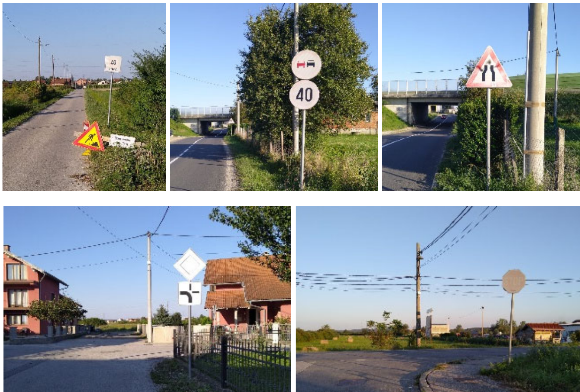
Slika 32. Oštećeni prometni znakovi na području naselja Soblinec i znakovi kojima je istekao vijek trajanja
