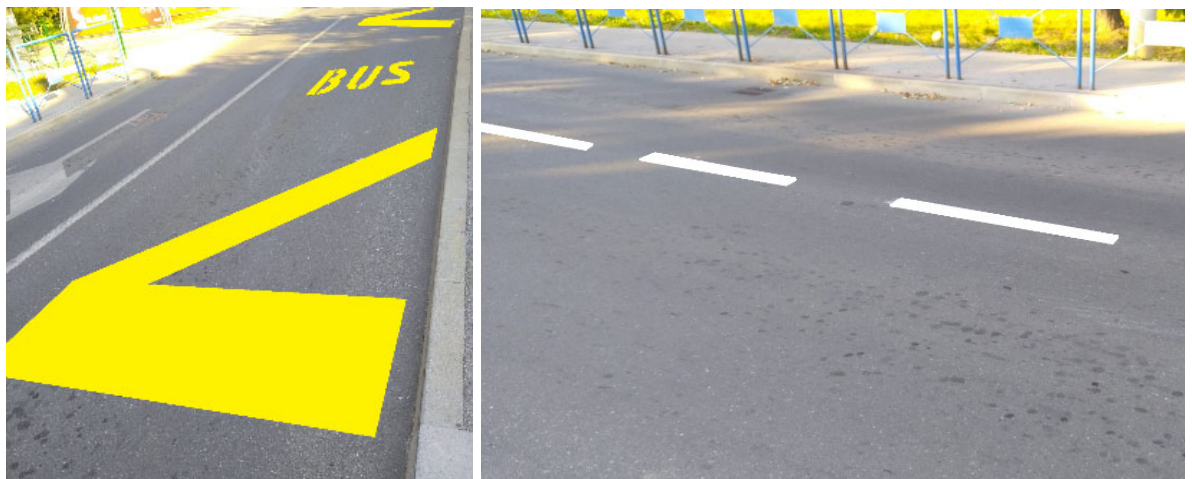
Slika 46. Prikaz obnovljenih oznaka na kolniku
