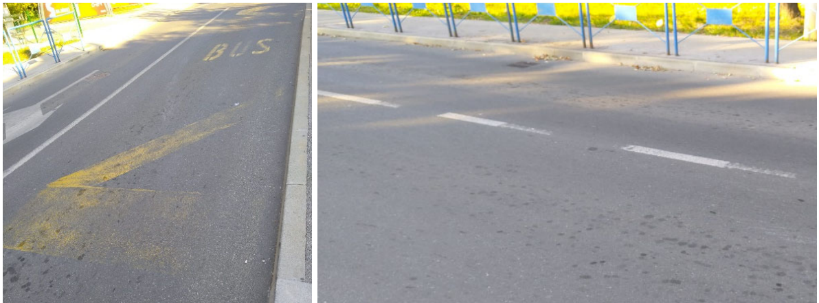
Slika 45. Prikaz potrošenih oznaka na kolniku
