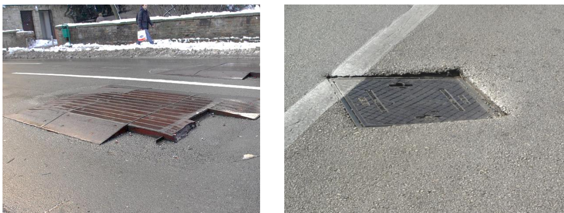
Slika 8. Primjer cestovnih elemenata koji predstavljaju rizik za vozače motocikala: a) uspornik, b) poklopac instalacijskog otvora
