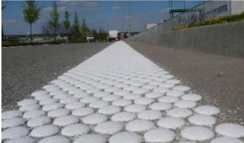
Slika 6. Strukturirana oznaka na kolniku [2]
