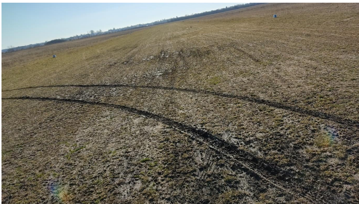
Slika 17.: Oštećenje na stazi za voženje (kolotruga)
