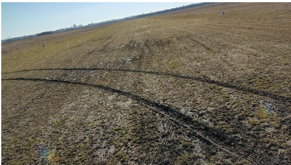
Slika 17.: Oštećenje na stazi za voženje (kolotruga)
