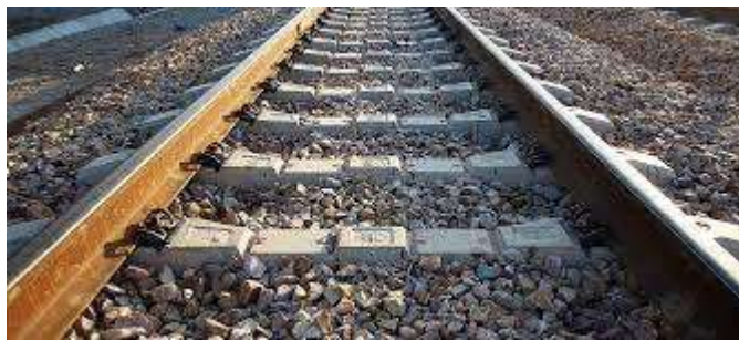
Slika 8. Kolosijek sa kolosiječnim zastorom[13]
