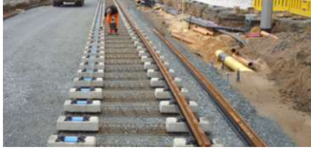
Slika 10. Izgradnja sustava „Rheda“ [15]
