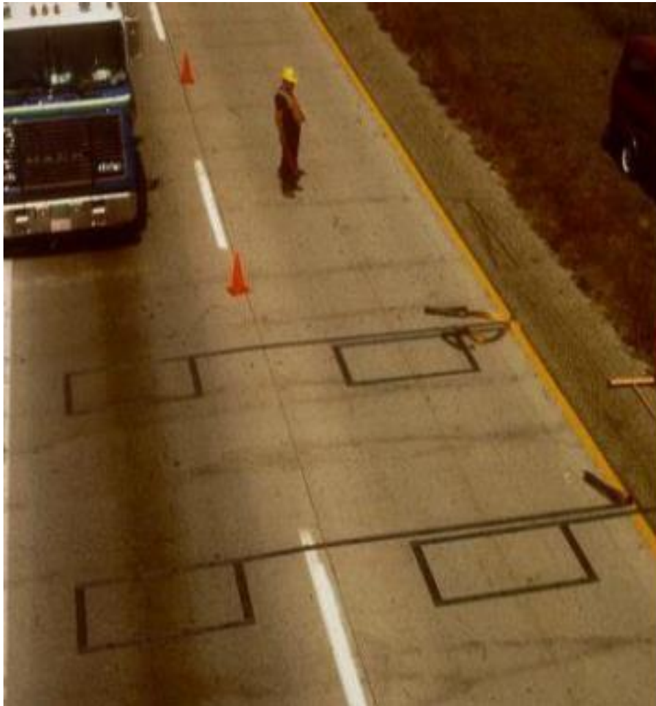
Slika 16. Indukcijska petlja Izvor: [6]
