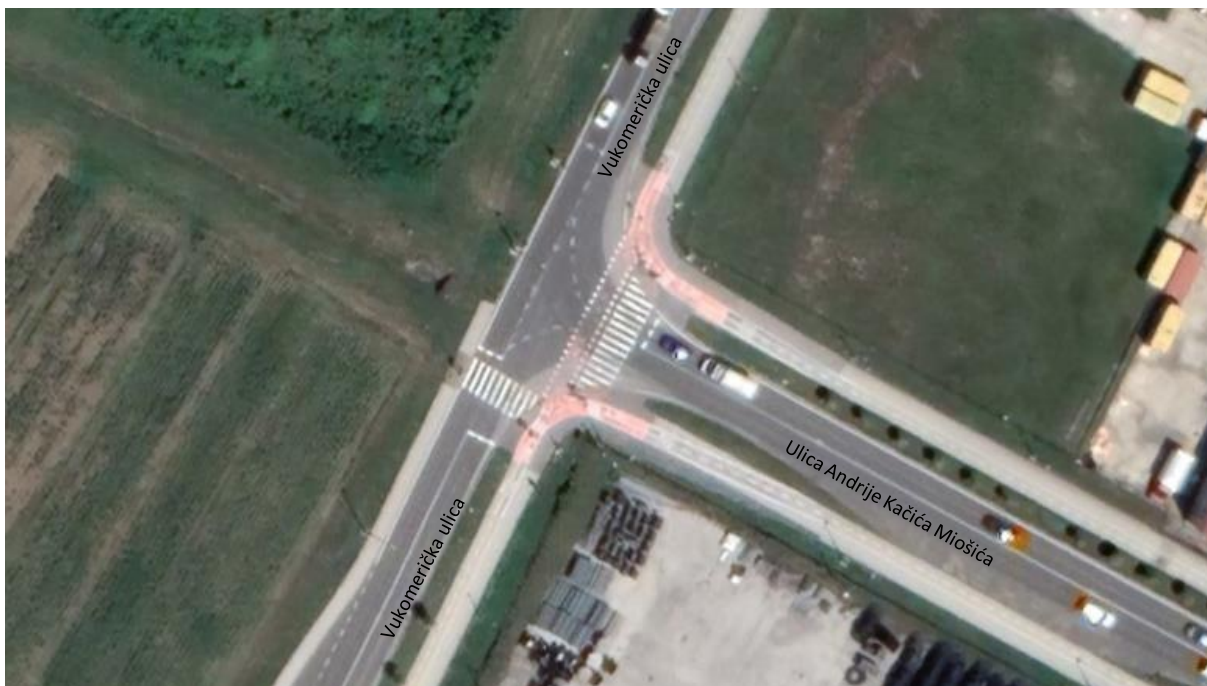
Slika 2. Uža zona obuhvata predmetne dionice – raskrižje 1. Izvor: Google Earth Pro
