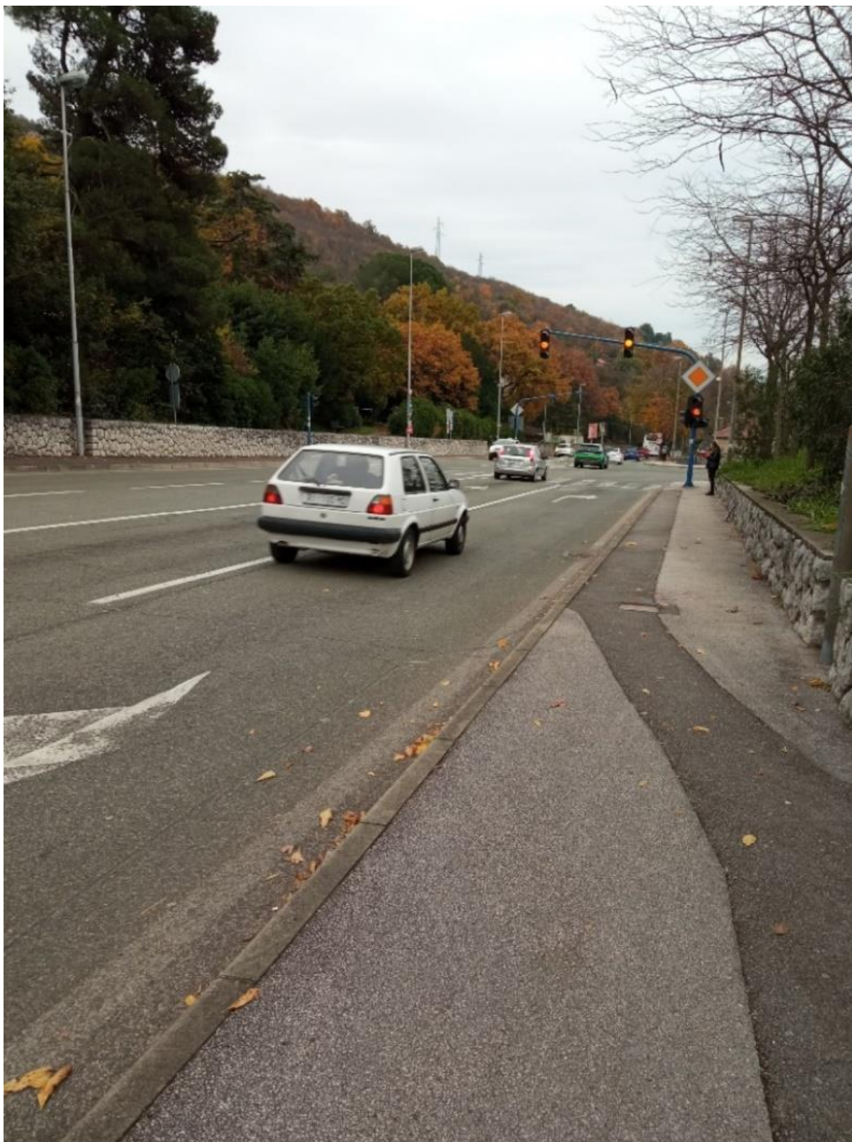
Slika 12. Pogled na privoz 2 i pješački prijelaz
