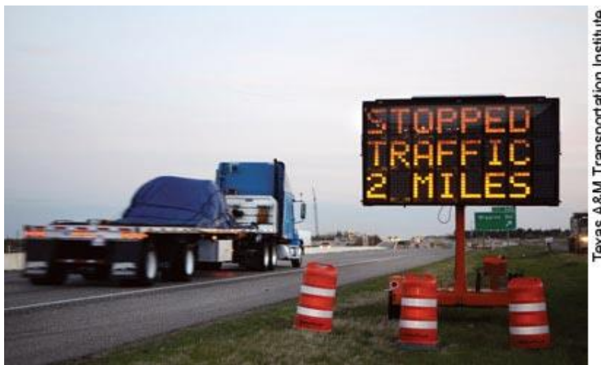
Slika 36: Inteligentni promjenjivi prometni znak sa sensorom
