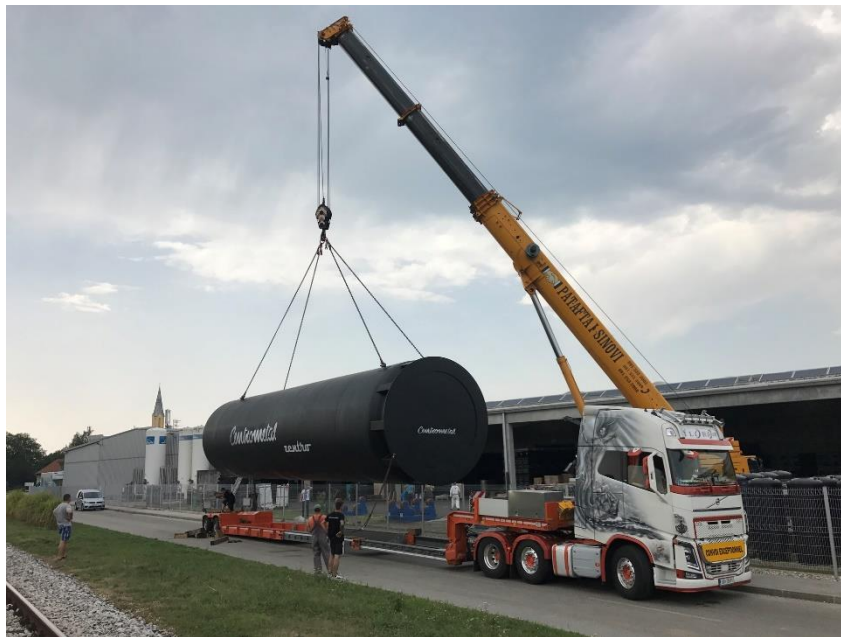
Slika 15 Utovar, centriranje i učvršćivanje tereta
