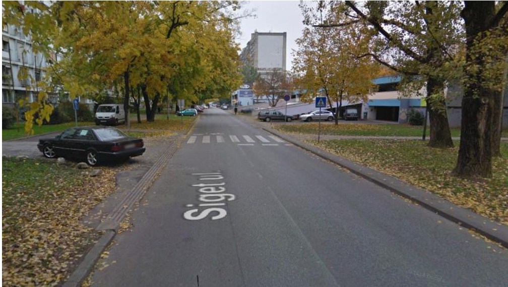
Slika 10. Pješački prijelaz neprilagođen osobama sa invaliditetom 13
