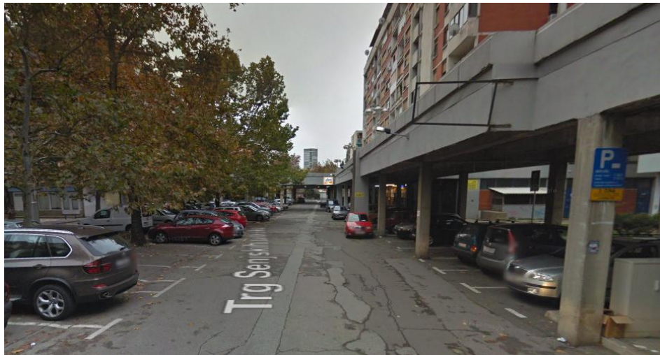
Slika 14. Neodržavanje prometnih površina 17
