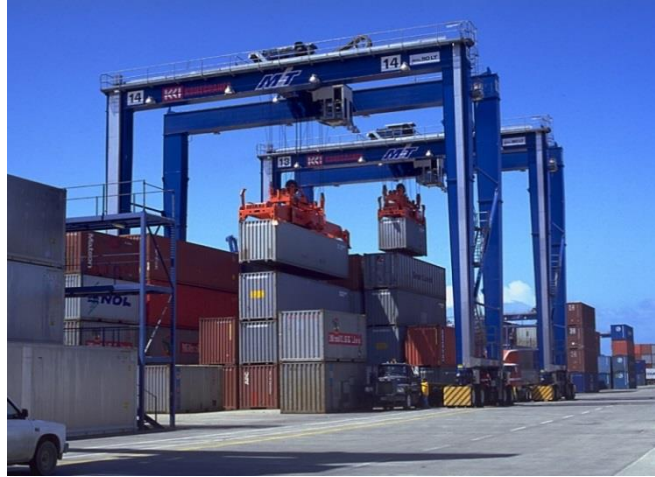
Slika 22: RTG dizalice na skladišnom prostoru Izvor: www.konecranes.com
