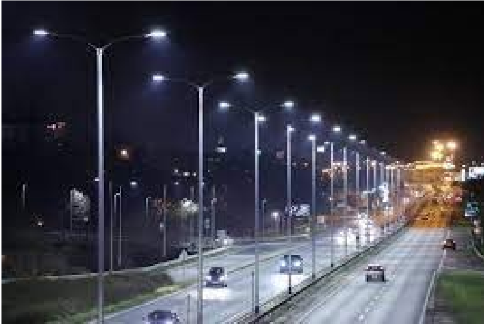
Slika 15. Centralni raspored izvora svjetlosti
