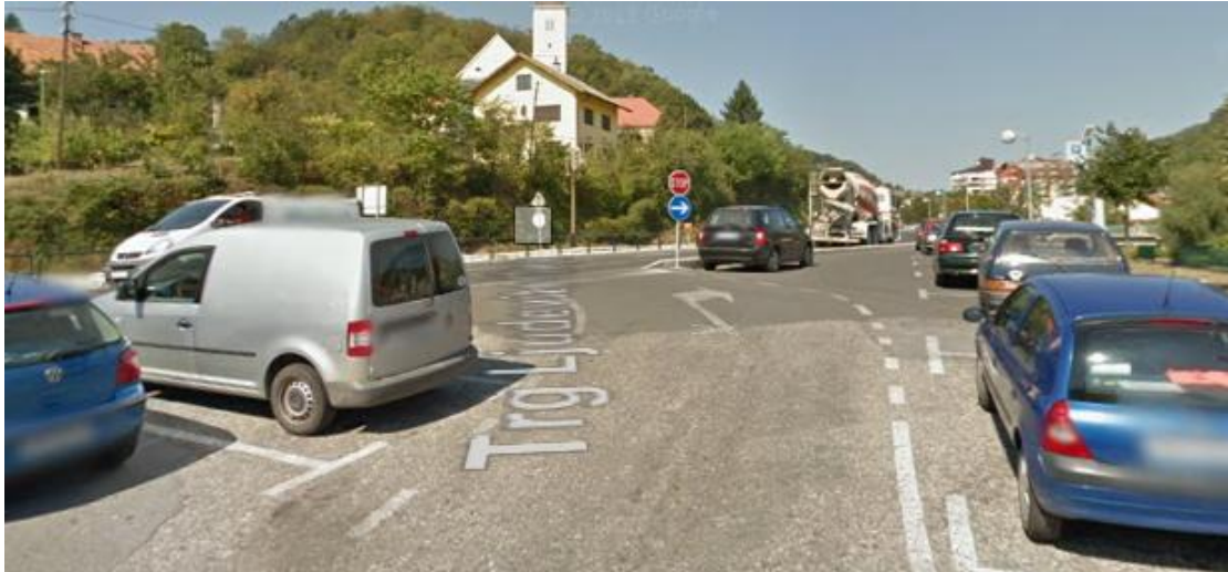
Slika 27. Stanje prije rekonstrukcije
