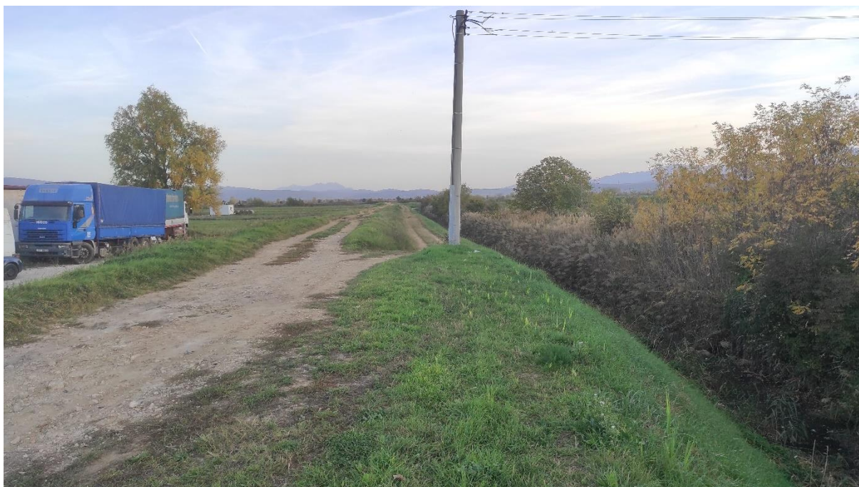
Slika 7. Poljski put uz kanal za oborinske vode
