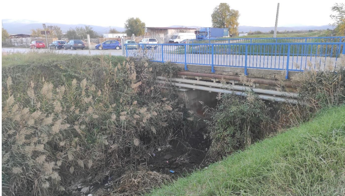
Slika 8. Most na L67040 preko kanala
