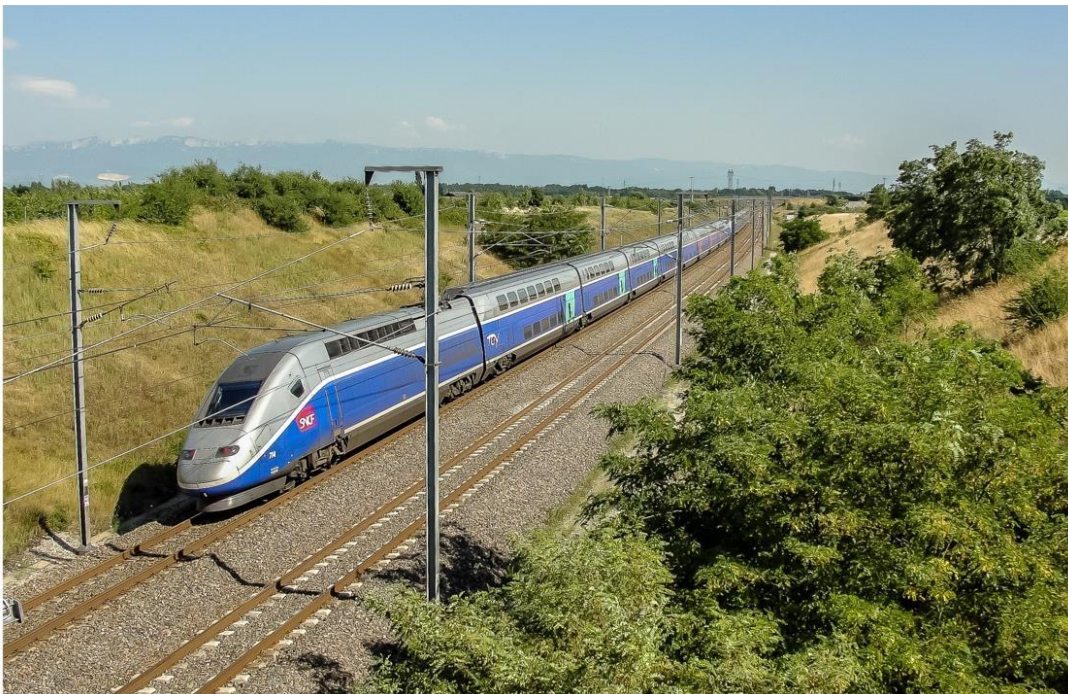
Slika 11. Kolosijek LGV željeznice na liniji Lyon-Marseille
