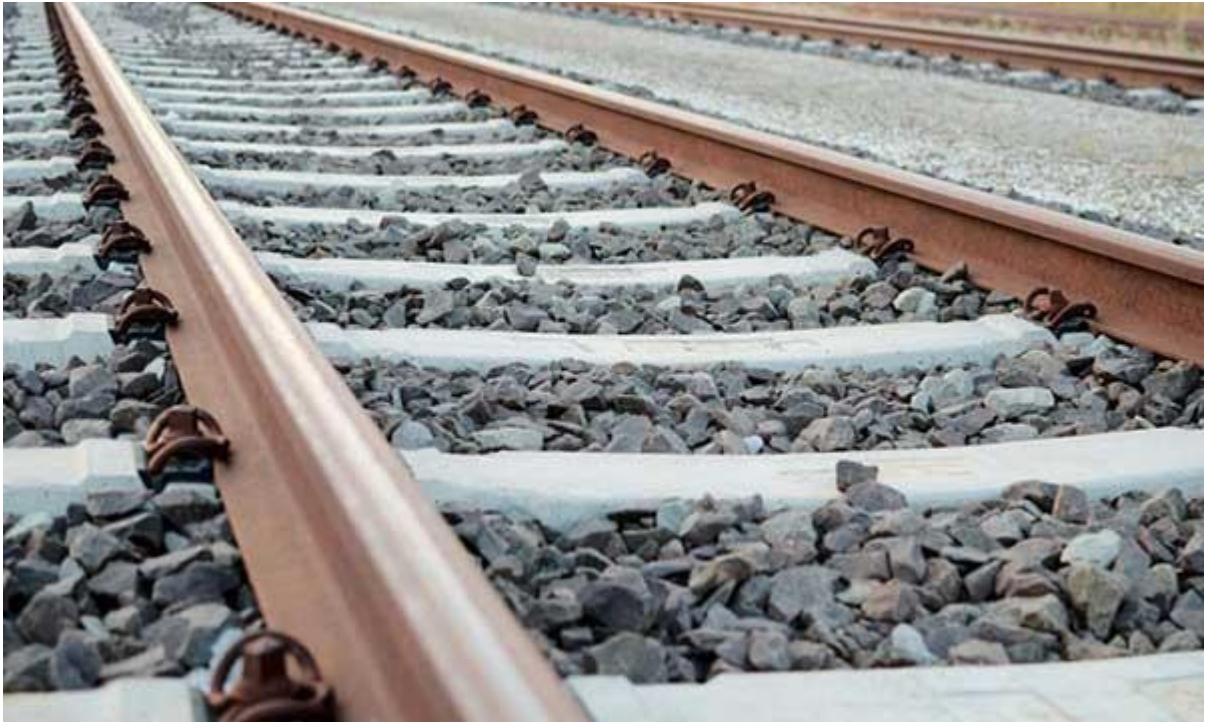
Slika 10. Kolosijek sa zastorom od tučenca
