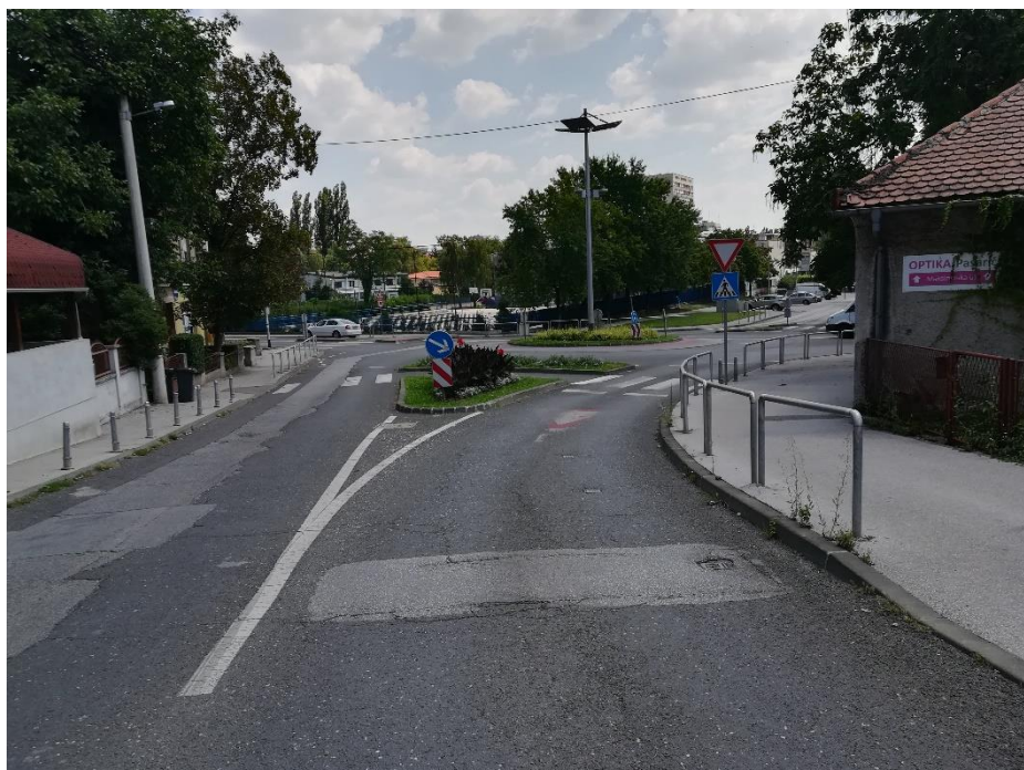
Slika 6. Sjeverni privoz raskrižja Petrova ulica – Ulica Jordanovac
