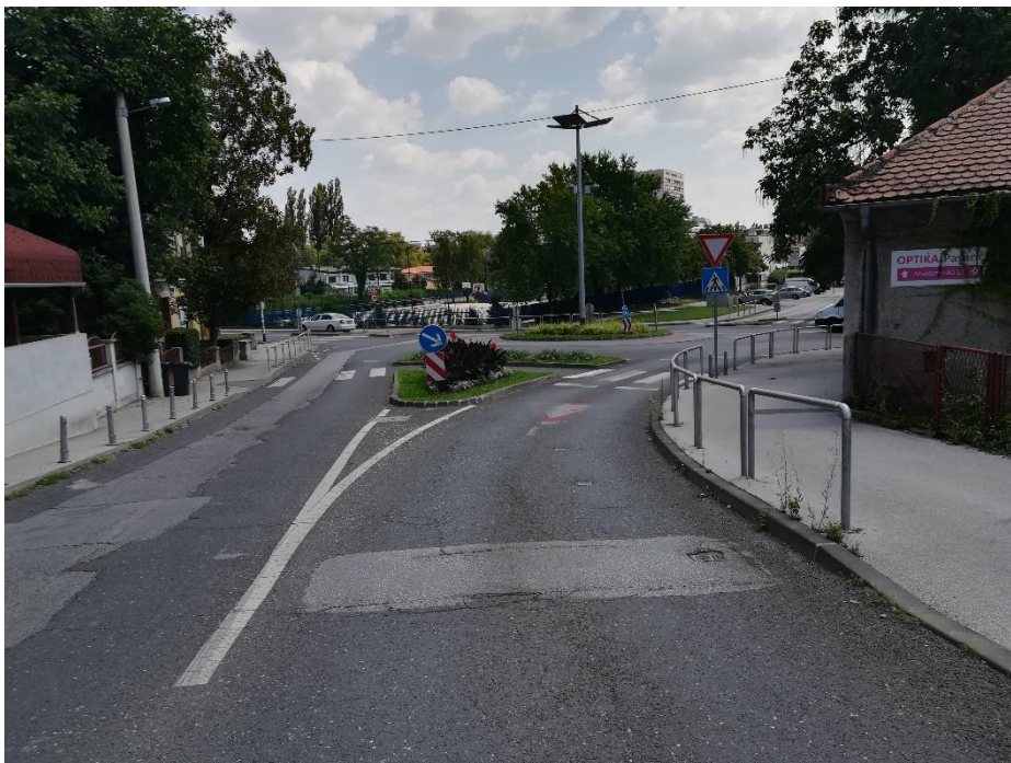
Slika 6. Sjeverni privoz raskrižja Petrova ulica – Ulica Jordanovac
