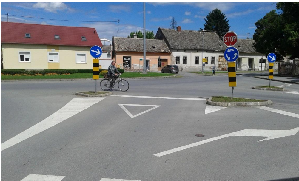
Slika 18.: Problem neusklađenosti prometne signalizacije
