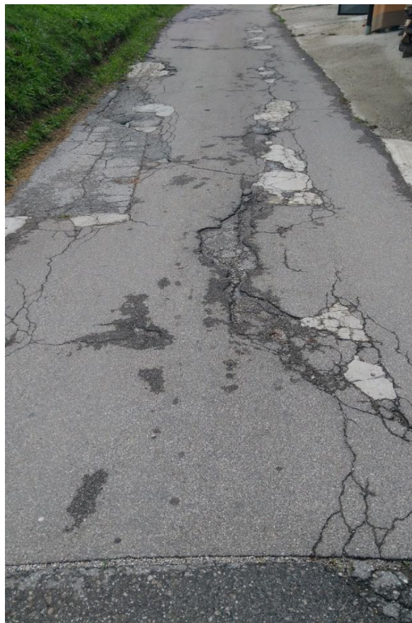
Slika 7. Pojava udarnih rupa u naselju Veliki Lipovec
