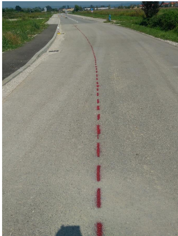
Slika 23. Crta vodilja za rezanje asfalta
