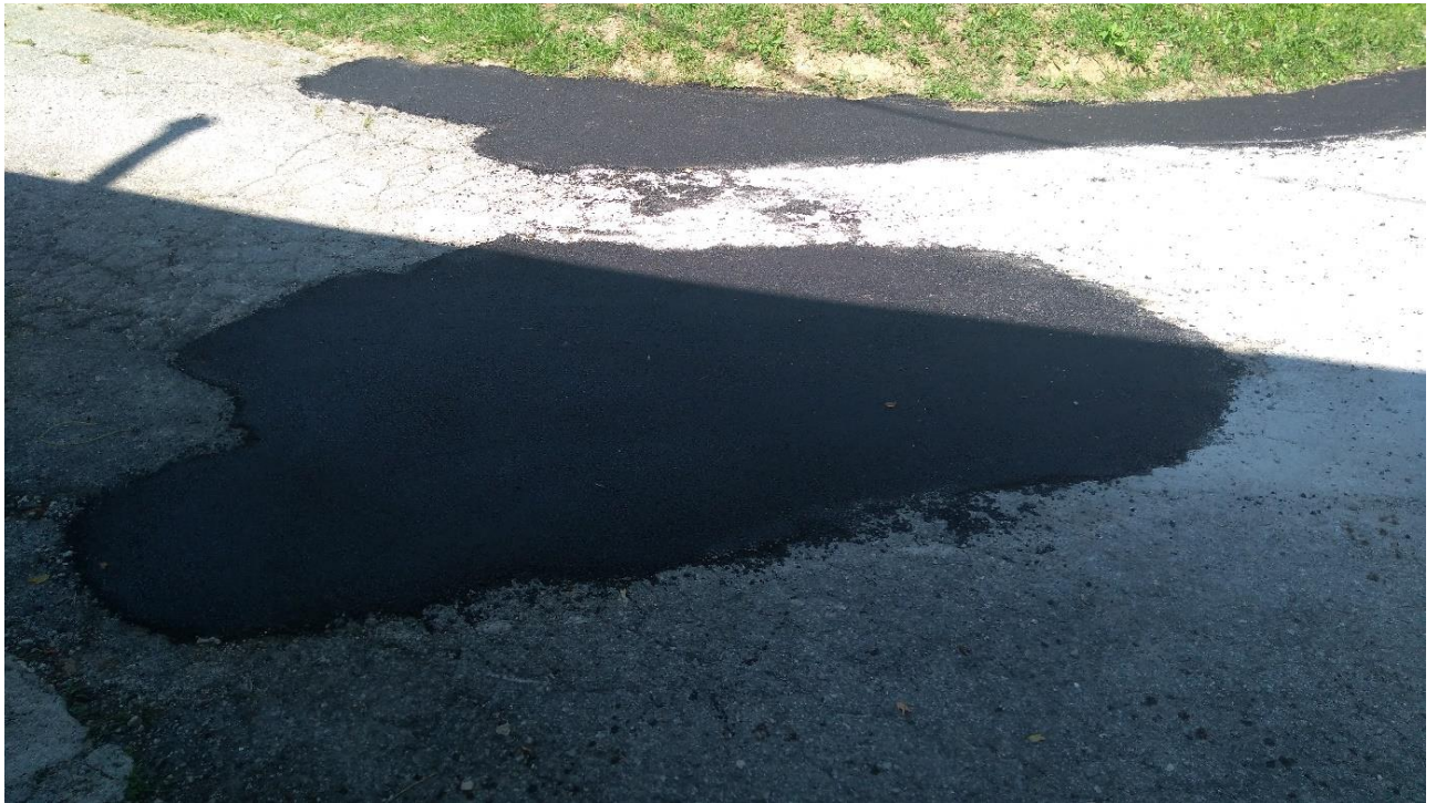
Slika 5. Prikaz udarne rupe nakon sanacije
