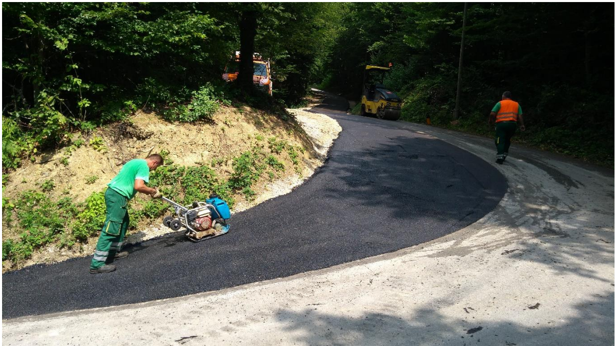
Slika 33. Zbijanje asfalta
