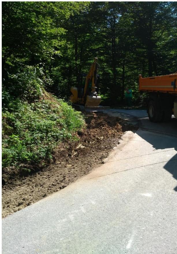
**Slika 29.** Skidanje materijala mini-bagerom s unutarnje strane zavoja
