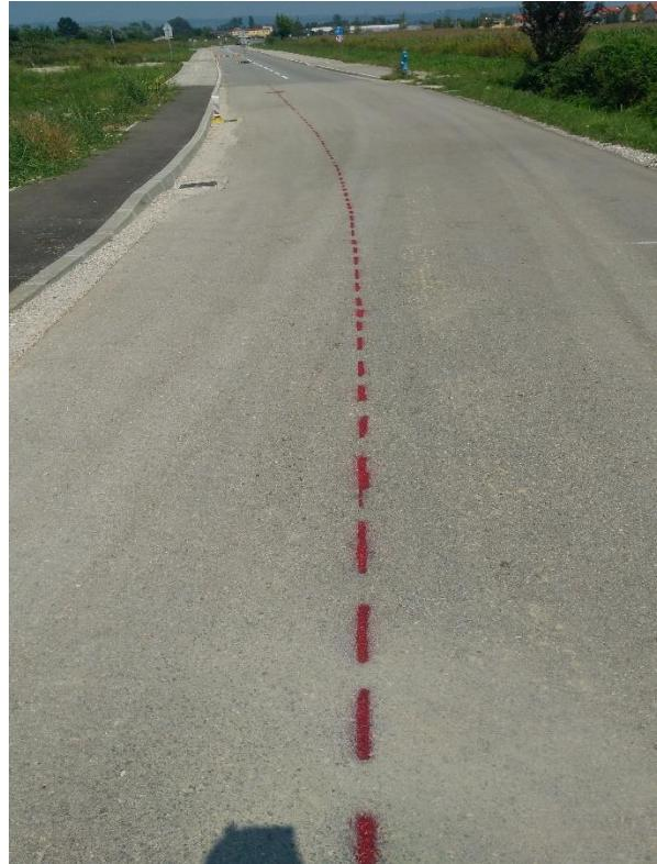
**Slika 23.** Crta vodilja za rezanje asfalta
