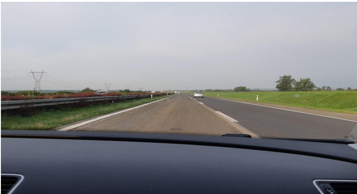
Slika 7. Postojeće stanje autoceste Zagreb - Karlovac
