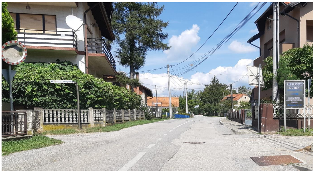
Slika 10. Naknadnim radovima narušena jednoličnost kolnika na ŽC2220 (Strmec Stubički (Ž2219) – Gornja Bistra – Novaki Bistranski – Ivanec Bistranski – A.G. Grada Zagreba)
