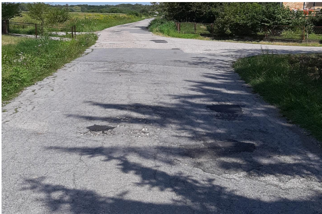
Slika 20. Dio kolnika lokalne ceste u naselju Donji Vukojevac
