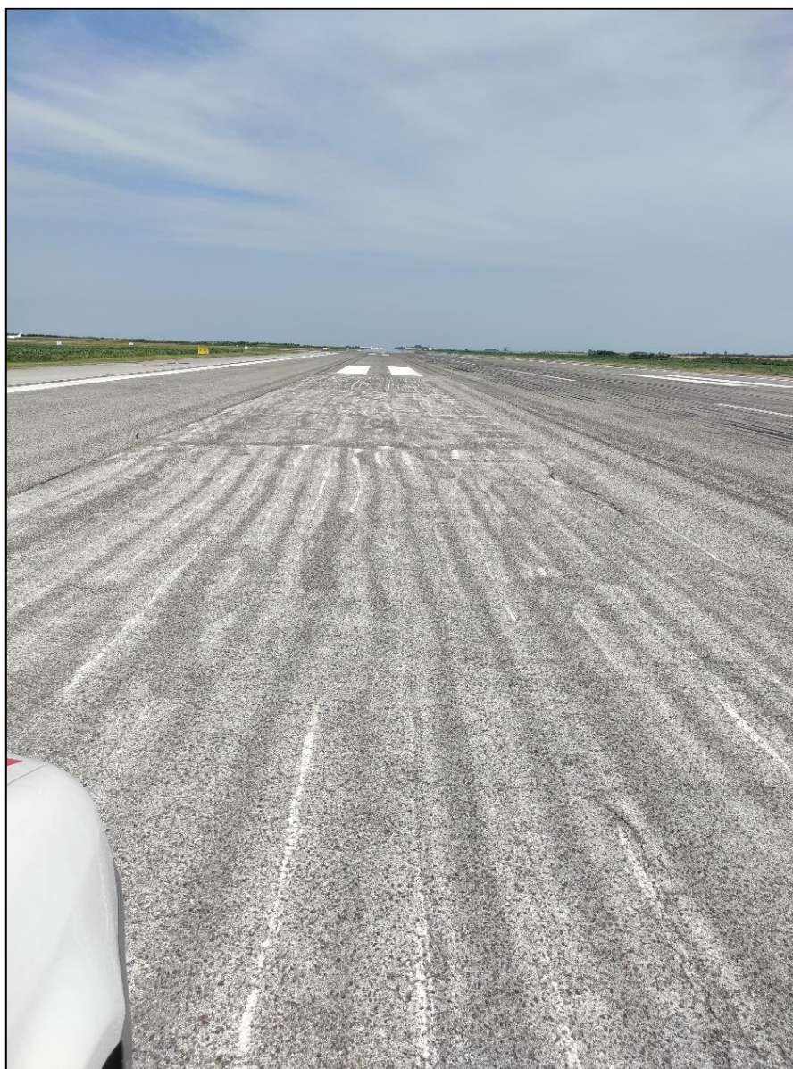
Slika 11. Prikaz oštećenja u zoni ciljne točke
