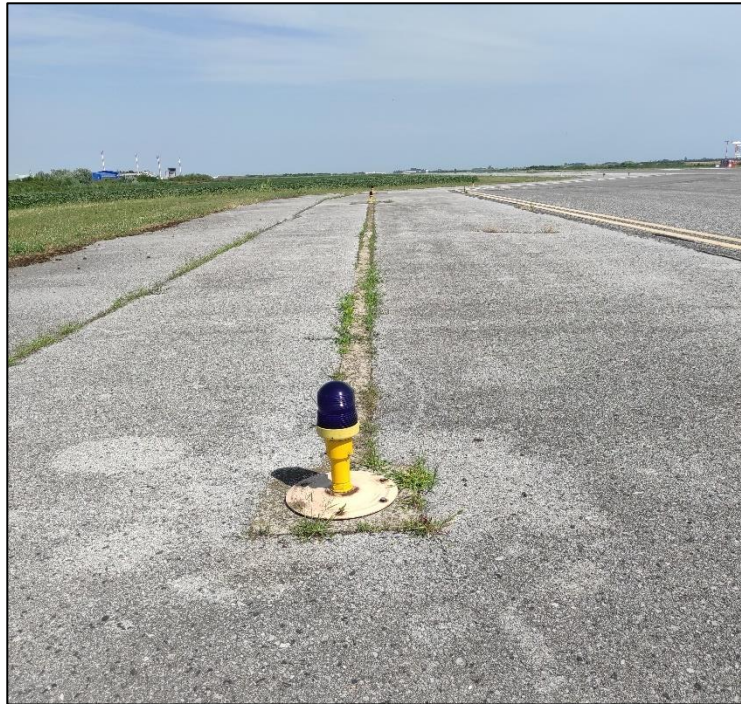
Slika 15. Stanje rasvjete na okretnici
