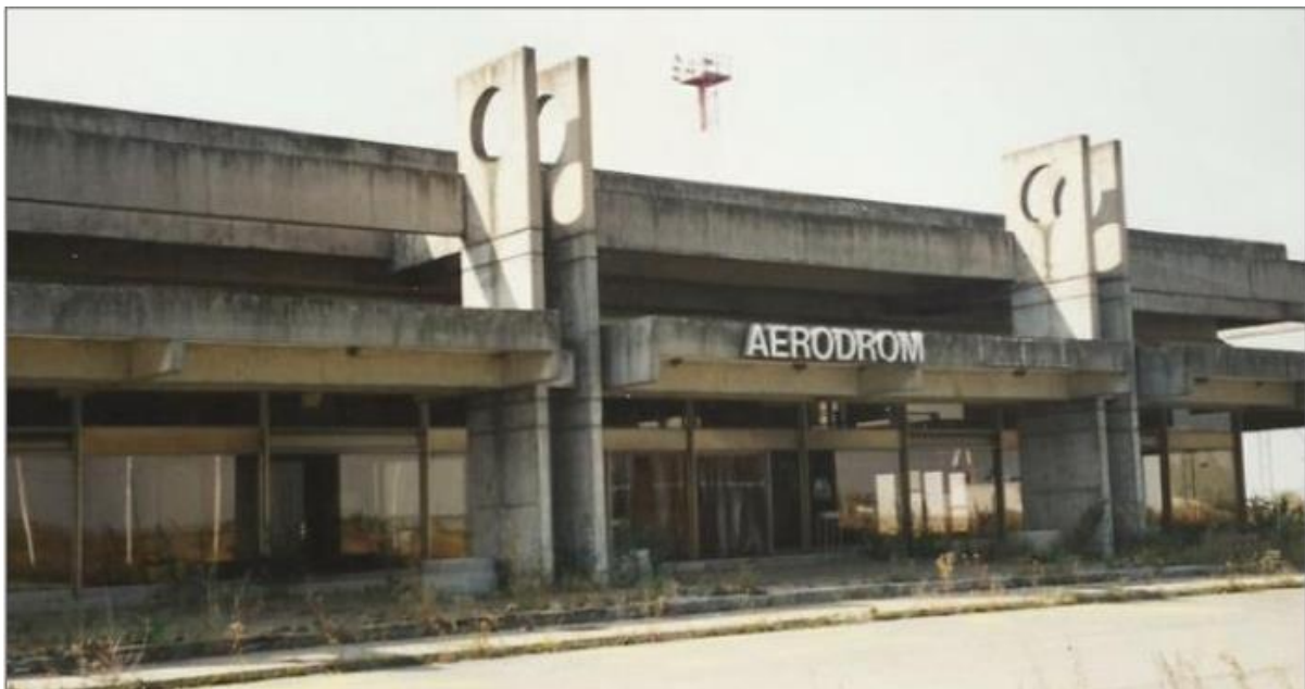
Slika 2. Prikaz uništene zgrade putničkog terminala Zračne luke Osijek, [3]
