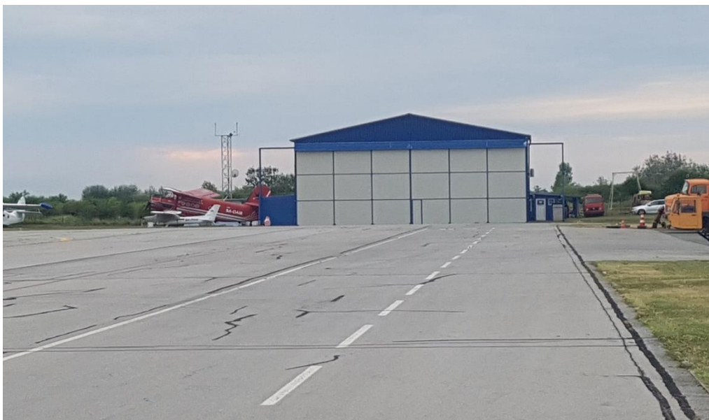
Slika 31. Hangar tvrtke Air Pannonia
