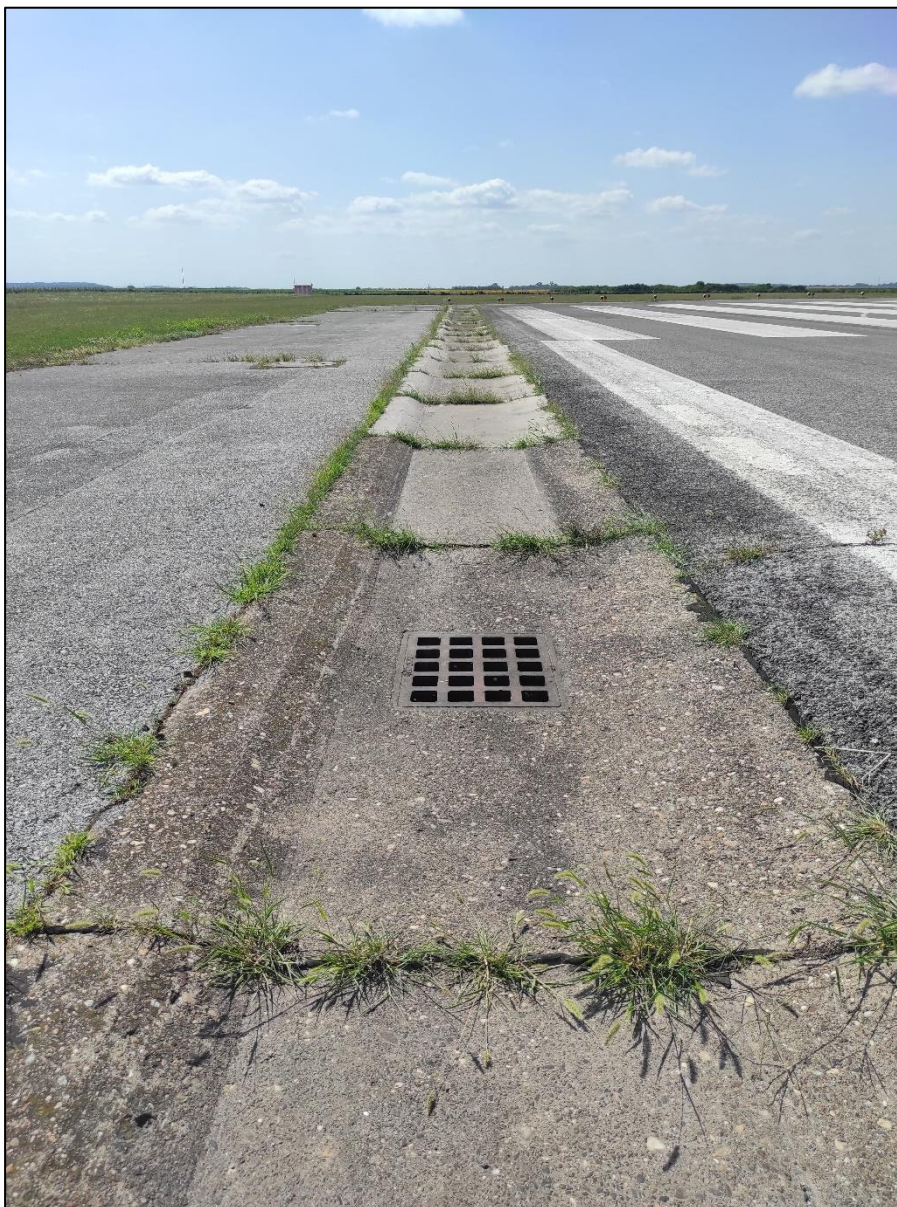
Slika 12. Rešetke za odvodnju
