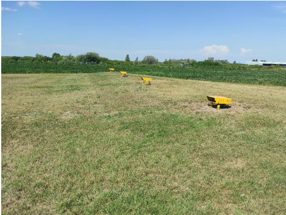
Slika 10. PAPI sustav Zračne luke Osijek
