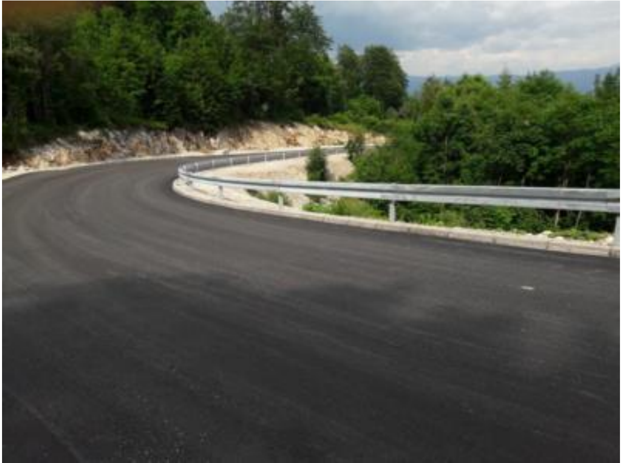
Slika 6. Zaštitna odbojna ograda u zavoju bez dodatnog elementa za motocikliste
