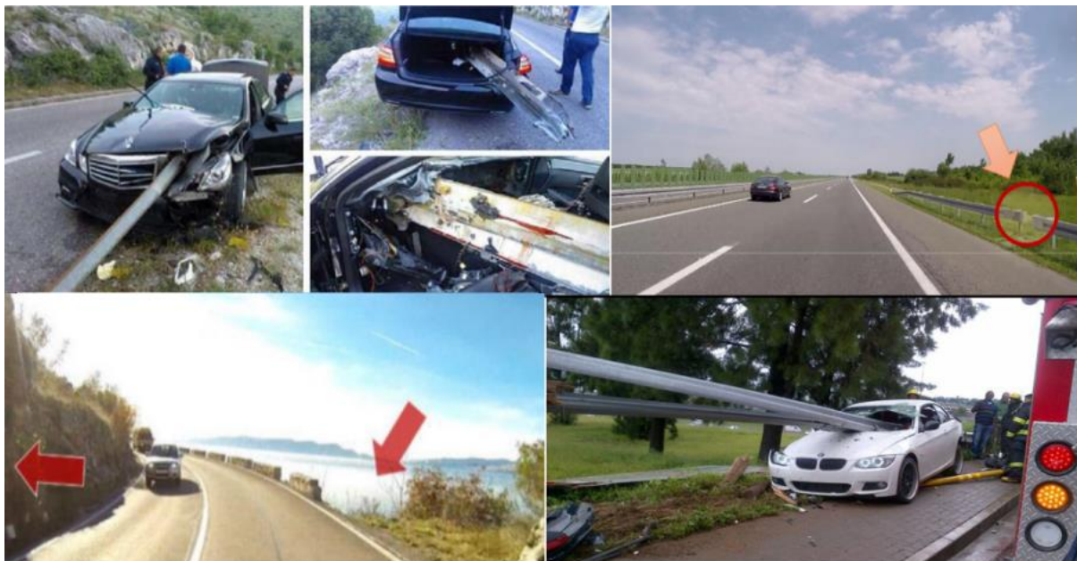
Slika 3. Posljedice neadekvatno postavljene zaštitne ograde
