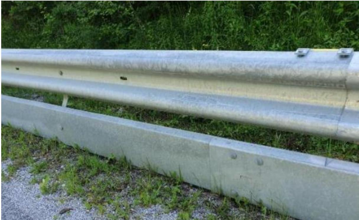
Slika 12. Zaštitna odbojna ograda s dodatnim elementom
