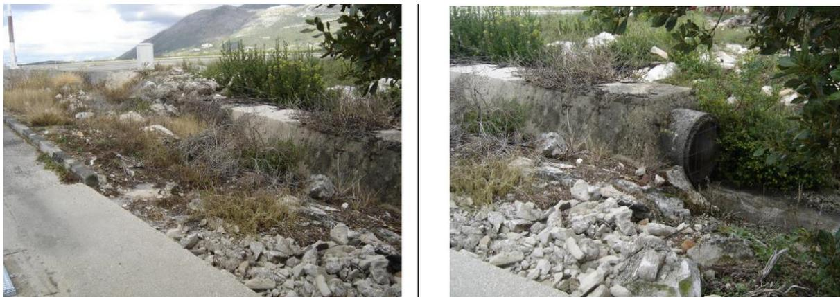
**Slika 7.** Cjevovod oborinske kanalizacije na istočnom kraju stajanke opće avijacije
