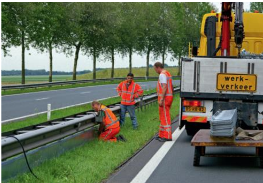
Slika 6. Postavljanje dodatne zaštite od podlijetanja u vidu čeličnog branika Izvor: [56]
