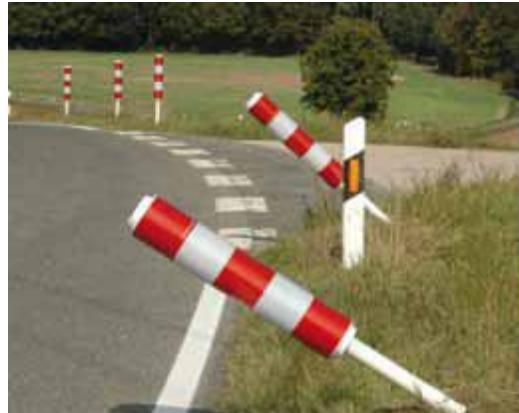
Slika 11. Smjerokazni stupovi izrađeni od savitljivog materijala
