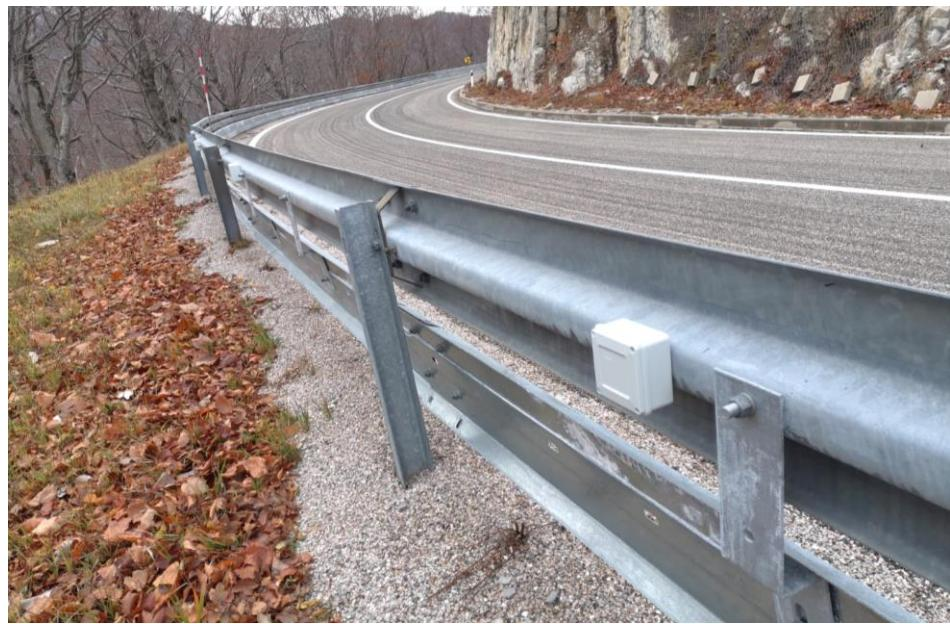
Slika 33. Senzor za detekciju udara na braniku ograde na DC25
