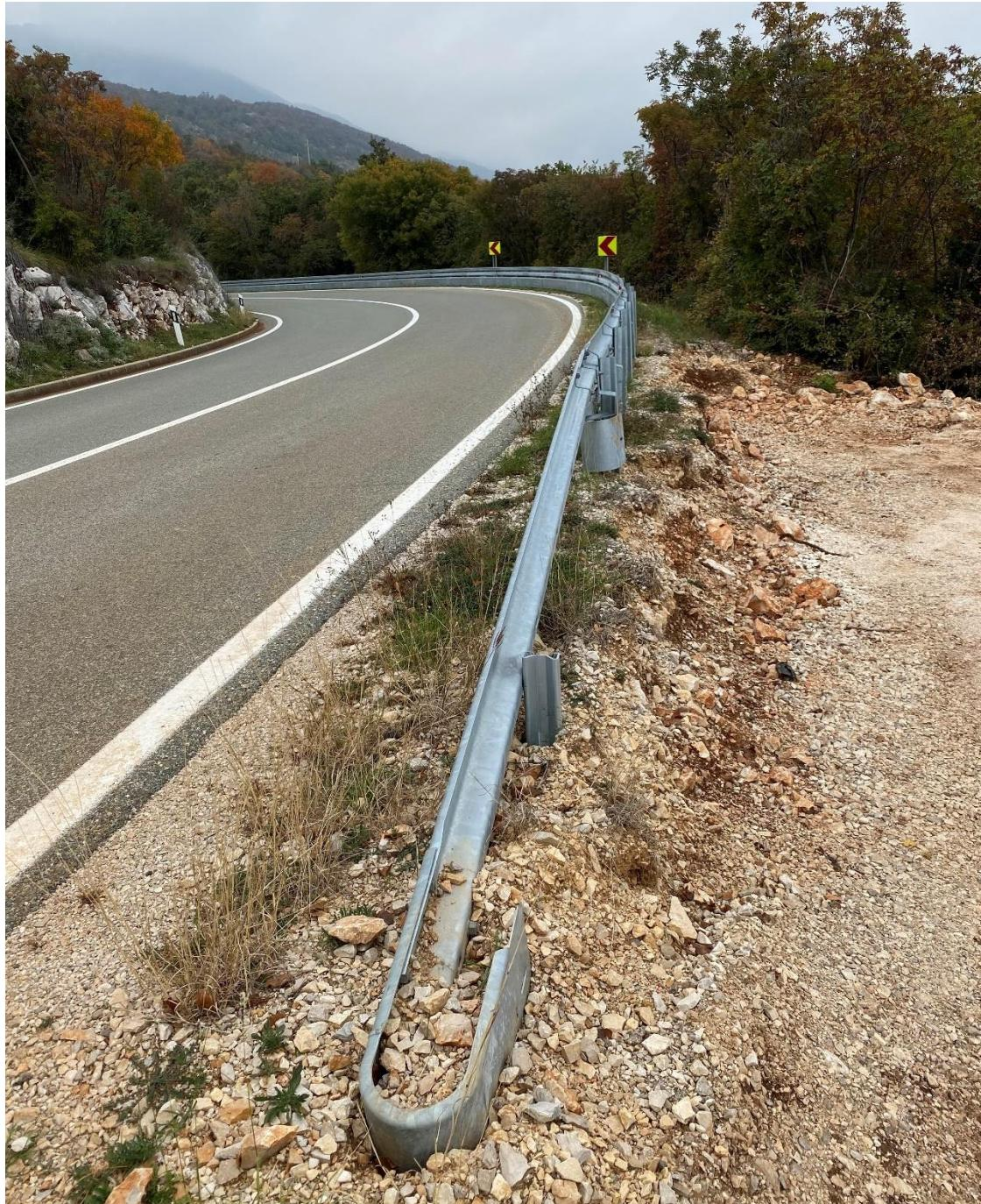
Slika 28. Izmaknuti ukopani terminal na ogradi s dodatnom zaštitom od podlijetanja i pločama K11-1 za označavanje opasnog zavoja na cesti (DC66)
