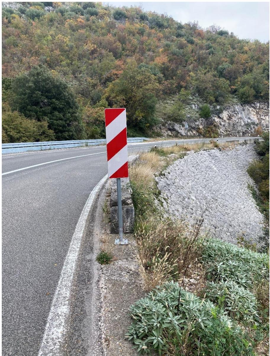
Slika 29. Ploča K12-1 za označavanje bočne zapreke (DC66)
