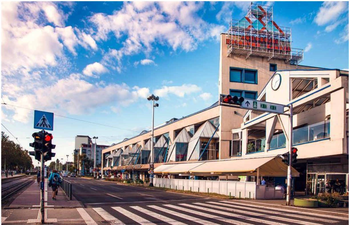
Slika 5. Autobusni kolodvor – terminal[10]
